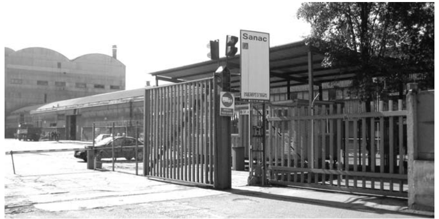
Gli impianti della Sanac. Restano ancora sotto sequestro
